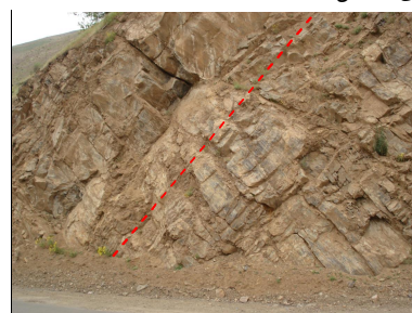
شکل ۳- حضور گسل و جهت گیری نامناسب درزه‌ها (۵)
