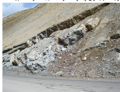
شکل ۵- لغزش رخ داده در محدوده ۲ در امتداد صفحه لایه بندی (ایستگاه ۱۷)
