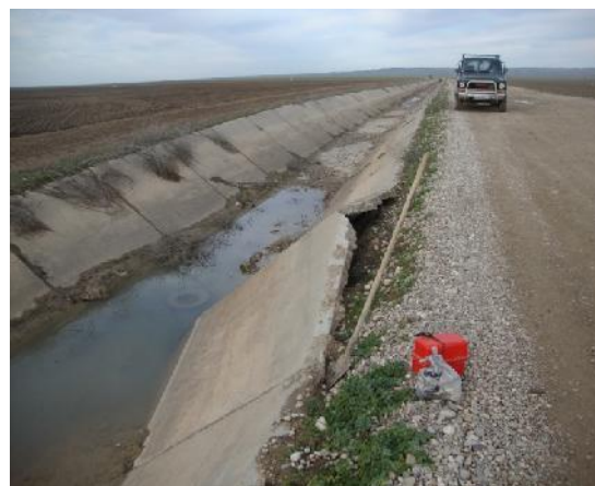
شکل ۲: شکستگی و تخریب کانال در اثر بارندگی های شدید و عدم تخلیه آن و نفوذ به زیر لاینینگ و جسم کانال.
