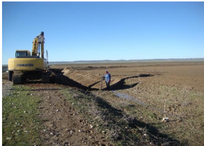
شکل ۶: اصلاح مقطع و تعمیق و لایروبی زهکش.
