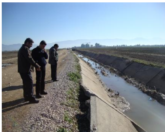
شکل ۲: شکستگی و تخریب کانال در اثر بارندگی های شدید و عدم تخلیه آن و نفوذ به زیر لاینینگ و جسم کانال.
