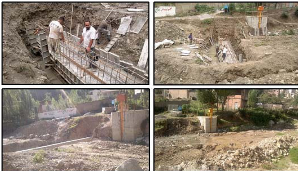
شکل ۷- نمونه ای از مراحل احداث کف بند - ایستگاه هیدرومتری زیارت استان گلستان
