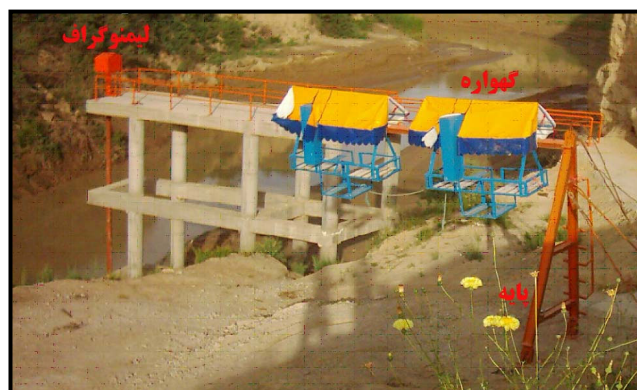
الف - پل تلفریک ایستگاه هیدرومتری چات - استان گلستان
