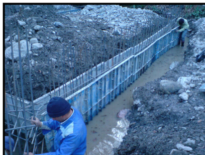
د - قالب بندی پی سازه
