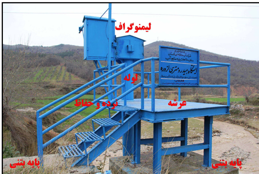
شکل ۴- نمونه ای از احداث لیمنوگراف از نوع لوله ای - ایستگاه هیدرومتری لزوره استان گلستان
