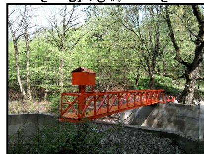
ک - تکمیل مقطع کنترل ایستگاه هیدرومتری
