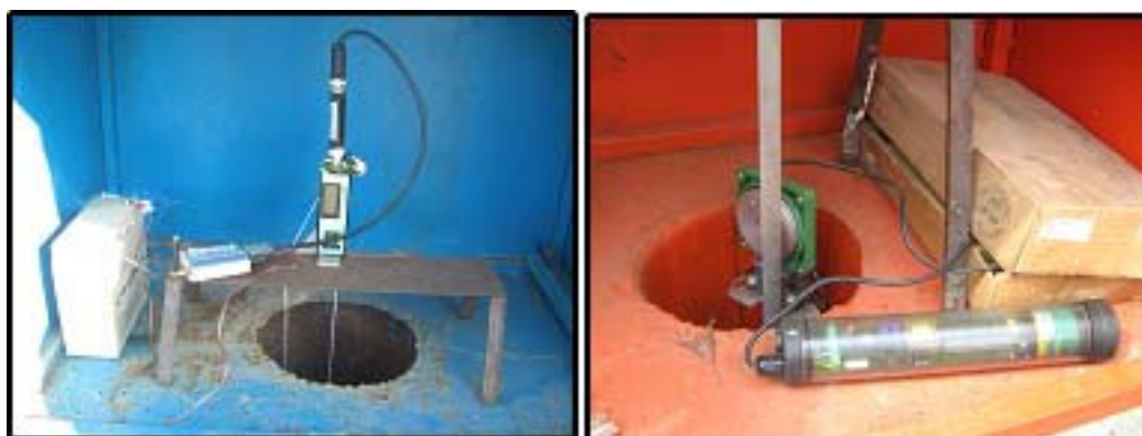
شکل ۱۰- دستگاه های سطح سنج الکترونیکی و مودم GSM منصوب در ایستگاه های هیدرومتری استان گلستان
