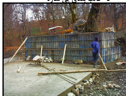
و - احداث دیواره های جانبی
