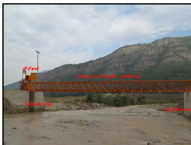
ب - پل ساختمانی - فلزی ایستگاه هیدرومتری نوده - استان گلستان شکل ۵- نمونه ای از احداث پل های اندازه گیری سیلاب ( الف و ب )
